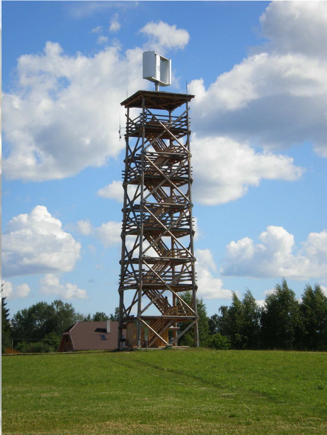
Elektrituulik Rõuges Tuuliku nimivõimsus on 3 kW
